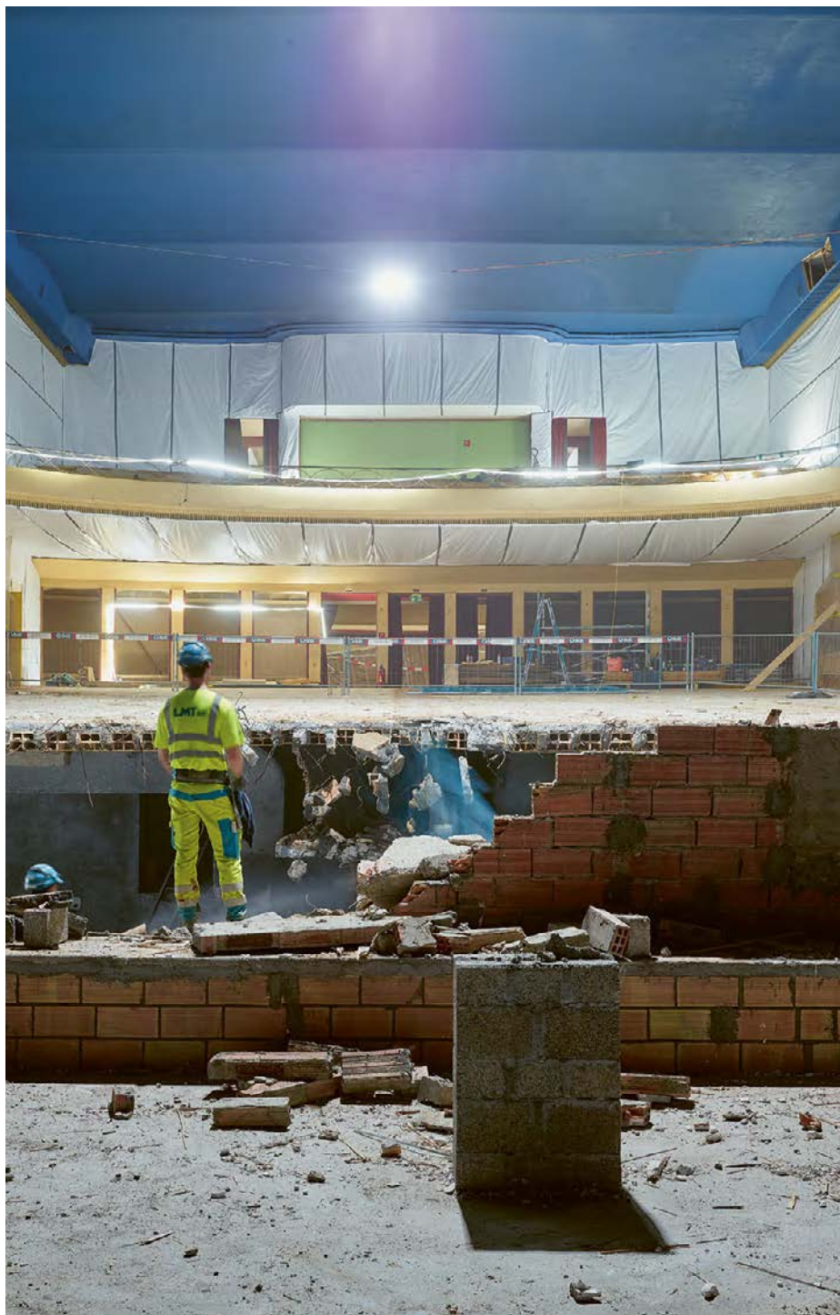
La grande salle du Capitole en pleins travaux. © Samuel Rubio
