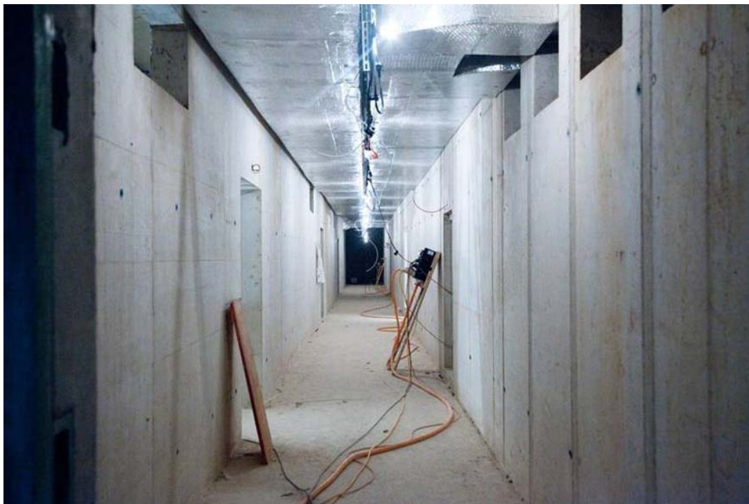
Le nouveau Centre de recherche et d'archivage de la Cinémathèque suisse en construction © Carine Roth
